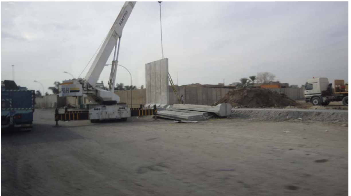
Hverdagsliv i Bagdad: Montering av beskyttelsesmur i veikanten.
