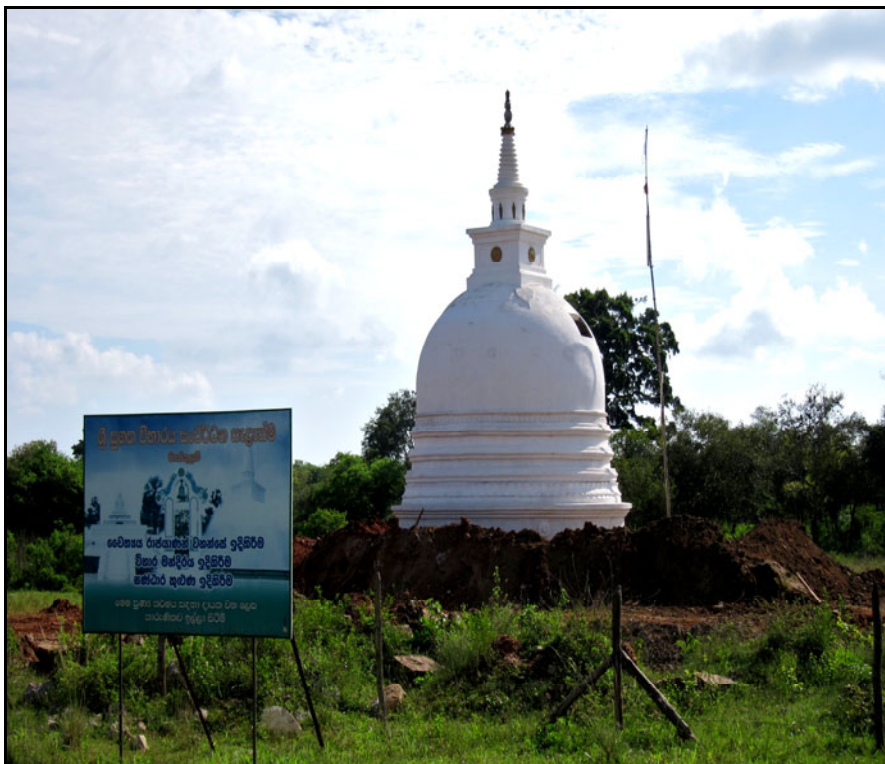
Stupa under konstruksjon i Killinochchi.
